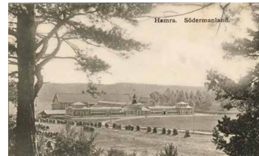
En bild av Hamra Gård från tidigt 1900-tal
